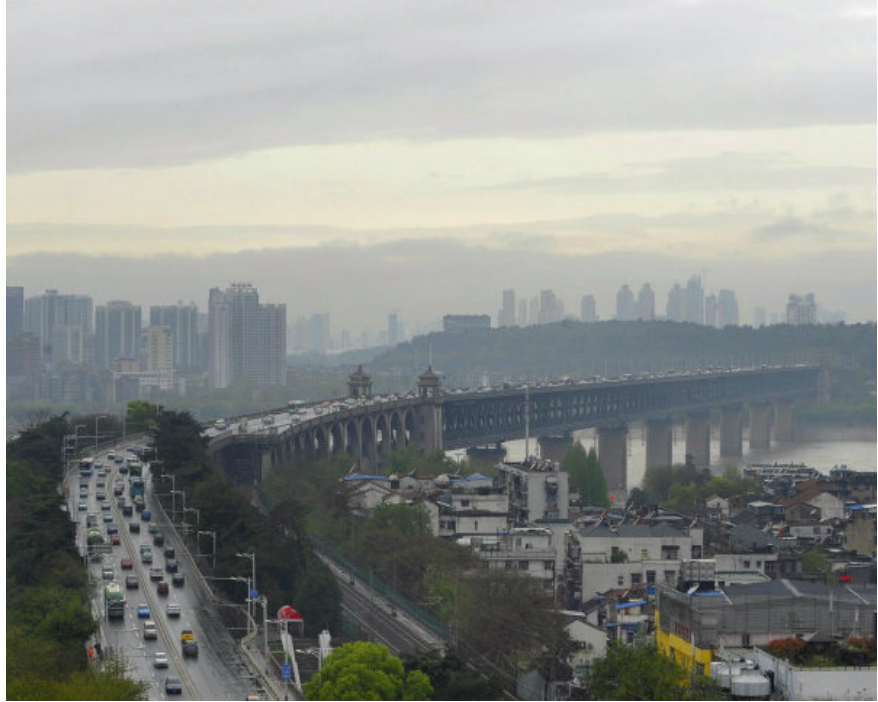
پل ووهان تیان ژینگ ژو، سازه ای دو منظوره (هم جاده ماشین رو و هم ریل قطار) با هزینه ای معادل ۱,۷ میلیارد دلار بر روی رودخانه یانکتزه در شهر ووهان بنا شده است) the big bridge (Both road and rail car train ) Wuhan Tian Xing Zhou
